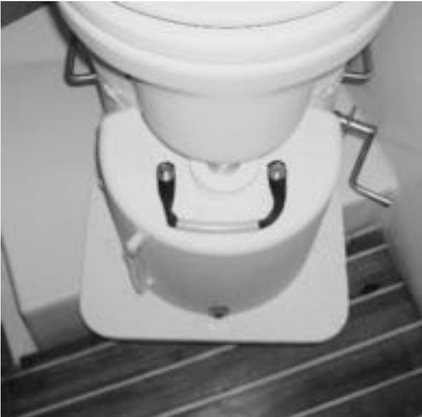
Bei Montage auf einer Stufe muss der Urintank mindestens 5cm auf der Stufe stehen. Oder eine Bodenplatte verwenden.
